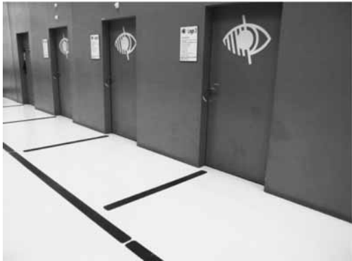
圖 18 該館提供之視障者專區，除門上繪製清楚標示外，地面上亦鋪設導盲磚，讓視障者可順利進入專屬空間
